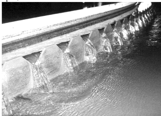
Рис. 4.1.4.1. Перелив радиального сгустителя, получаемый после осветления
